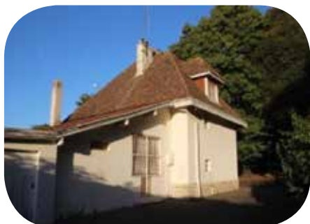
Vue extérieure de l'ancien presbytère
